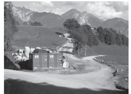
Giggelberg: Allein die vorher nicht geplante Neuerstellung und Verbreiterung der äußeren Giggelbergstraße mit Regenkanal und Steinschichtung verursachte Mehrkosten in Höhe von rund € 126.000. Foto hag
