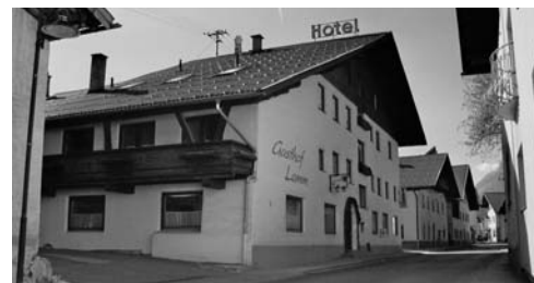
Gasthaus Lamm 2006 vor dem Abbruch
