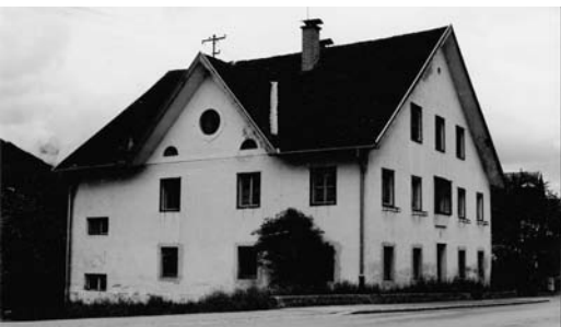
altes Fischlhaus 2002 vor dem Abbruch
