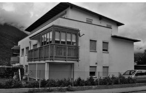
Wohnanlage neu Salzstraße 22
